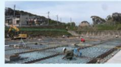
C,D工区 デッキプレート、断熱材敷設、スラブ配筋の状況
