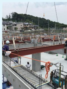
鉄骨梁の架設状況
